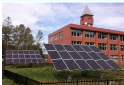
避難所に設置した太陽光発電
